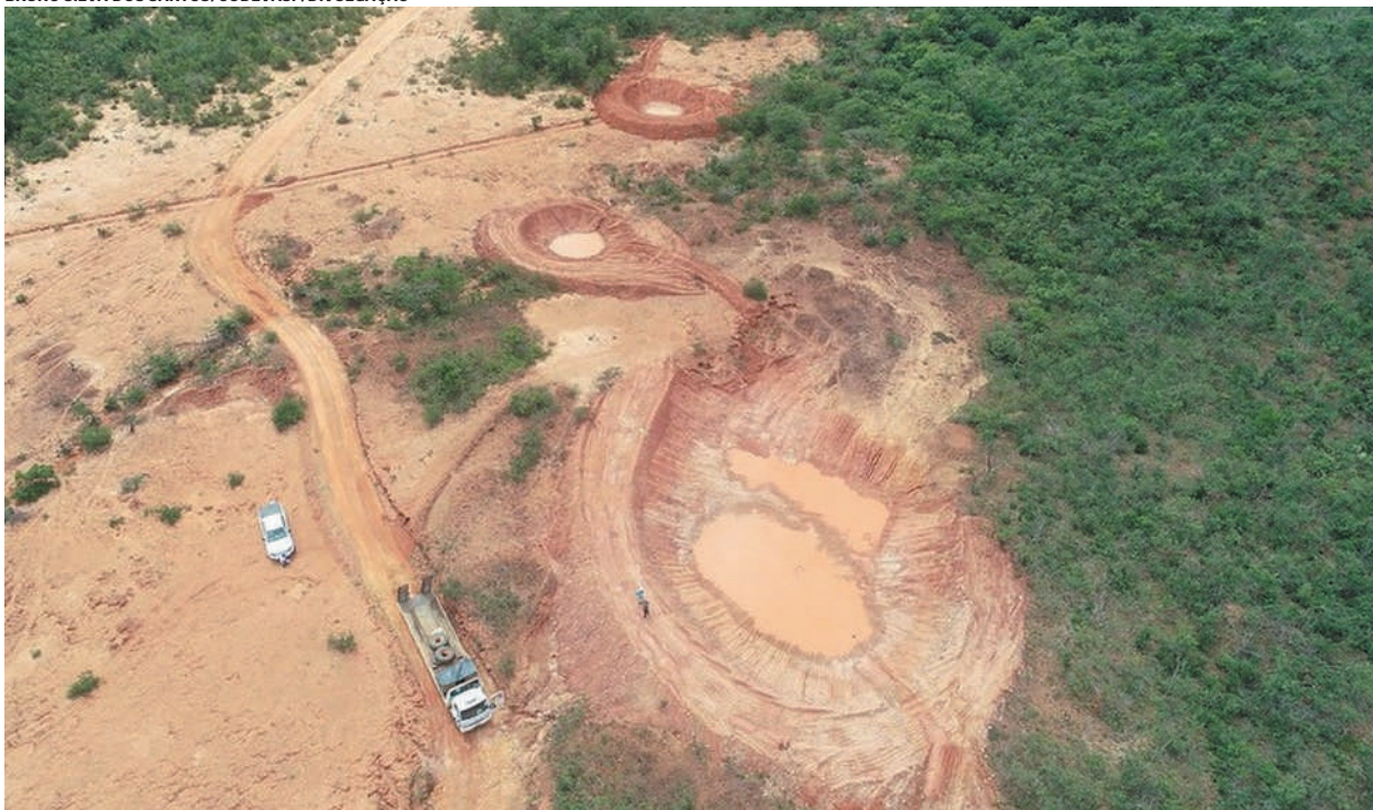
Construção da Barragem de Jequitaiá se arrasta há anos e freia desenvolvimento agropecuário da região
