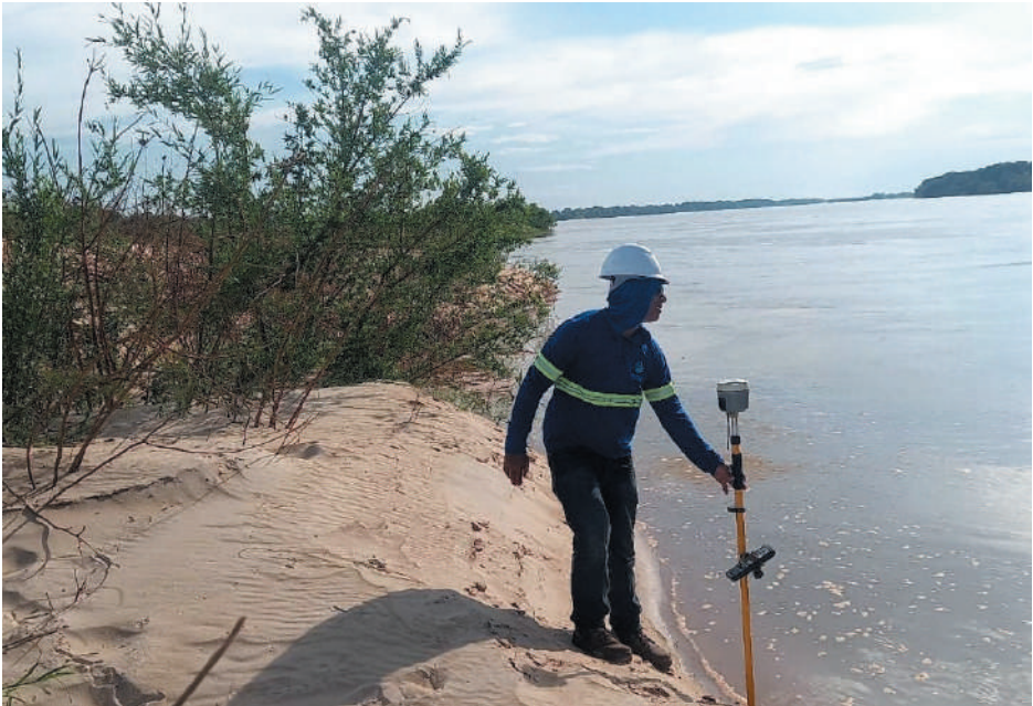
Estão sendo feitos o levantamento topográfico e a medição da profundidade do rio
