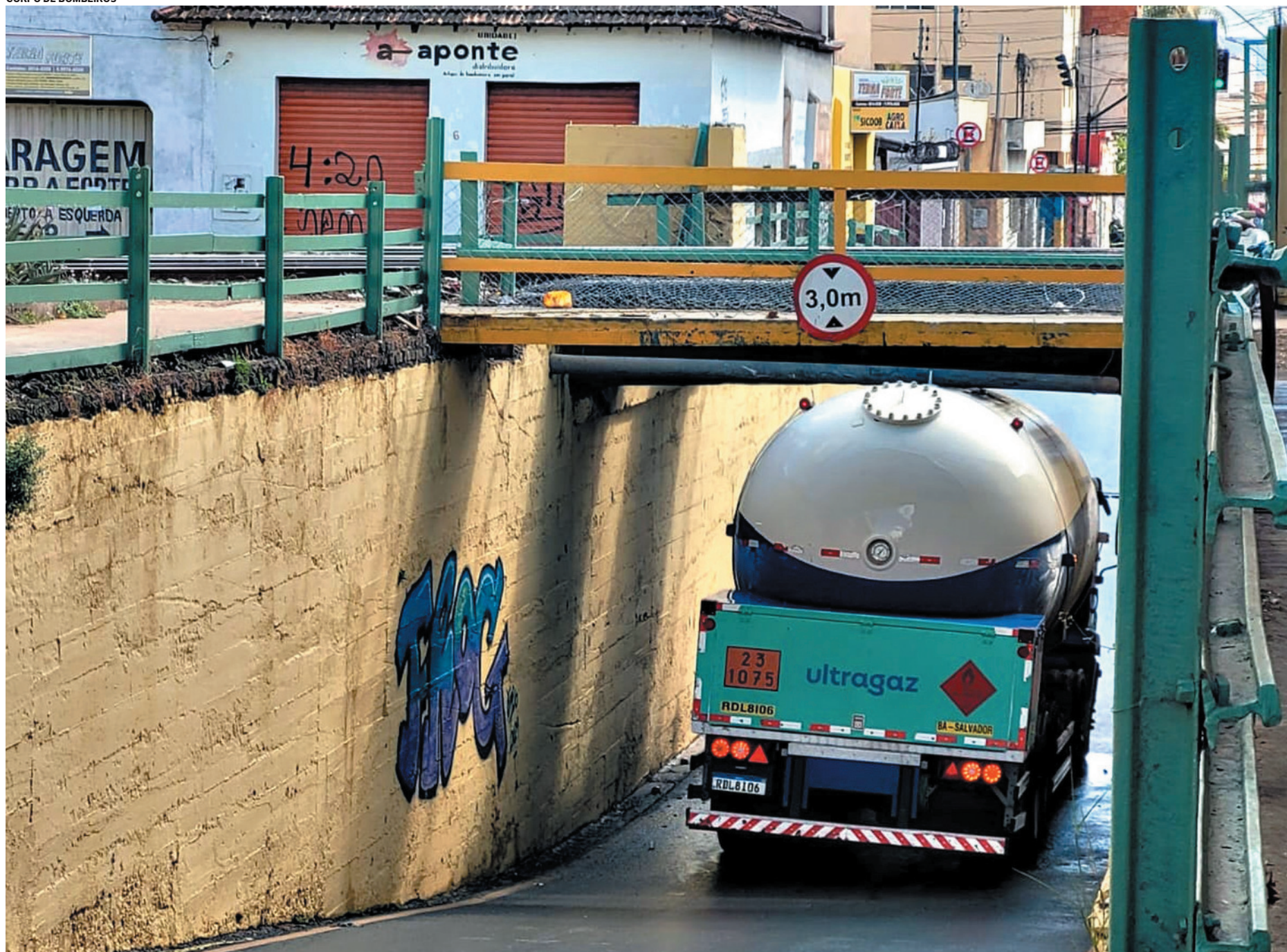
Moradores e estabelecimentos próximos ao viaduto foram evacuados por segurança, enquanto o Corpo de Bombeiros atuou para prevenir maiores riscos
